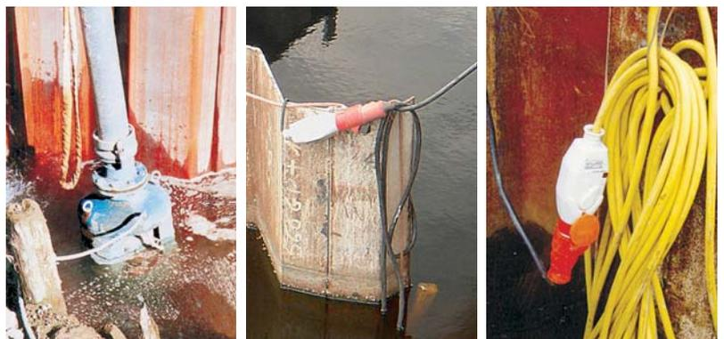
Der NIVA Niveauregler N1 kann überall eingesetzt werden, wo Flüssigkeitsstände überwacht werden müssen. Der Niveauregler N1 kann auch in Kombination mit der NOLTA Schützkombination 400 V, dem NOLTA Motorschutzstecker 230 V oder dem NOLTA Kondensatorstecker 230 V geliefert werden.
