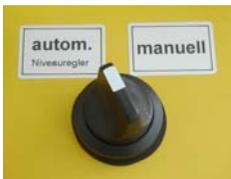
Drehschalter auf "autom." stellen. Der Softstarter wird jetzt ausschließlich über die Niveauregler gesteuert.
